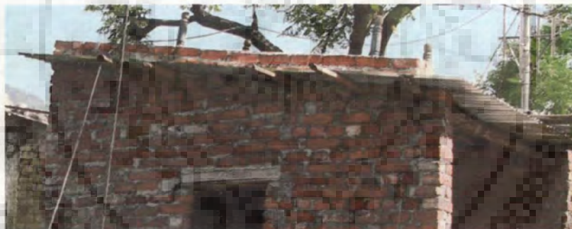
(d) Corrugated Galvanized Iron (CGI) Sheet Roof
