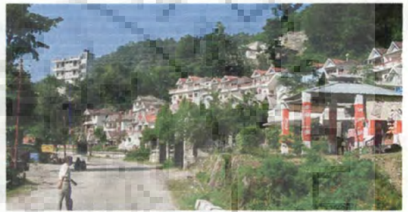
(d) Monitoring Centre, Tapowan
