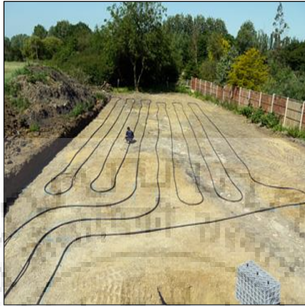
Figure 1.4 Linear type horizontal GHE
