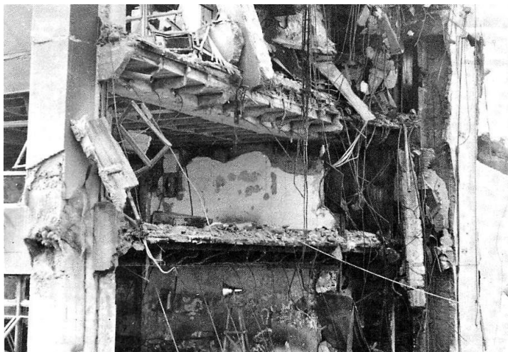
Fig. 1.12 - CESP 2 core collapse in Sao Paulo, Brazil (Beitel and Iwankiw 2002)
