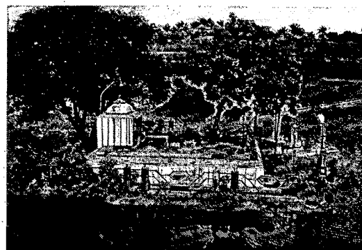
(d) Island Temple in the Tank
